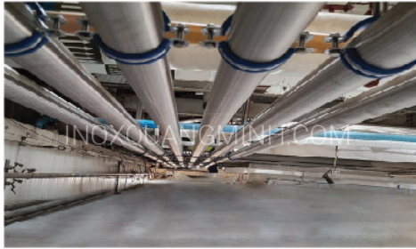
CONSTRUCTION / M&E CƠ ĐIỆN
